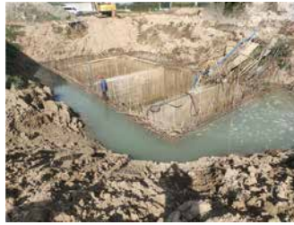
安徽亳州城南项目粗格栅沉井湿法作业
