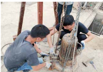
白山提升泵维修
