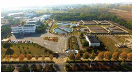
郎溪国祯污水厂实景
