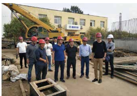
调研组考察武邑污水厂提标改造项目施工现场
