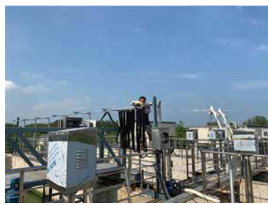
栏杆集二沉池抢修
