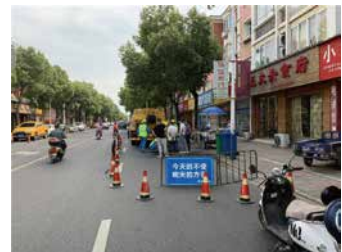
管网工作人员进行检修
