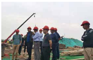
故城污水厂提标改造项目施工现场
