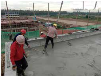
安徽亳州城南项目加药间浇筑砼
