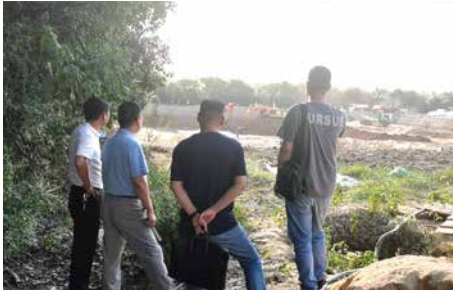
调研组实地察看郎溪国祯污水厂二期扩建项目
