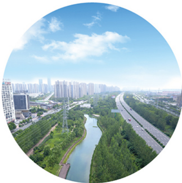
合肥滨湖新区塘西河水质治理工程
